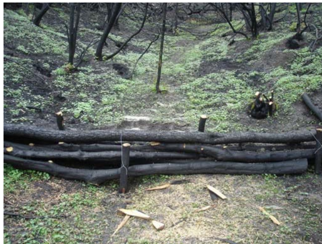
Σχήμα 2: Ξύλινα φράγματα στις κοίτες των χειμάρρων
